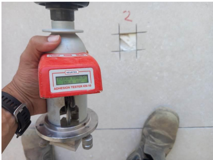
Imagen n°4. Equipo para el despegue de las probetas en obra
